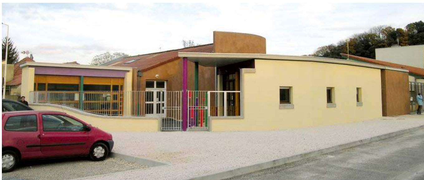
Le bâtiment du centre de loisirs maternel.
